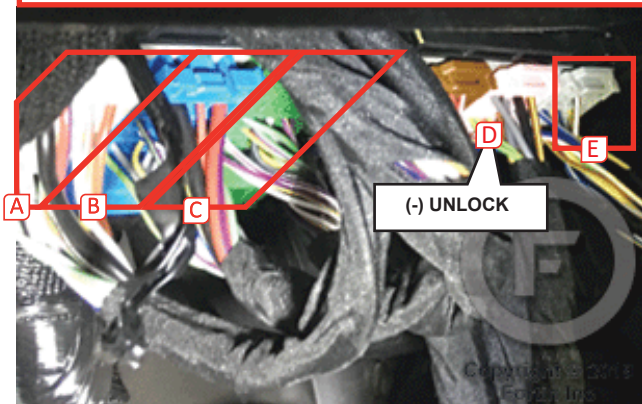
① BCM - Central Console, Driver side BCM - Console Centrale, Côté conducteur
