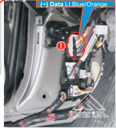
1 Drivers-side kick panel. Panneau Latéral côté Conducteur
