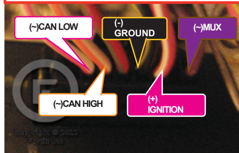
① At vehicle transponder connector Au connecteur de transpondeur du véhicule
