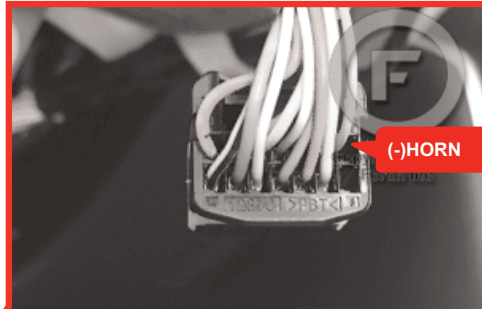
③ At Steering Column À la colonne de direction
