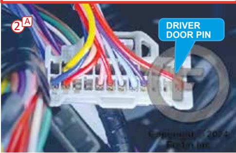
② BCM, behind dash fuse box BCM, sous le tableau de bord, boîte à fusibles.
