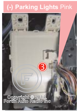
③ Behind Fuse panel Derrière la Boîte à fusibles
