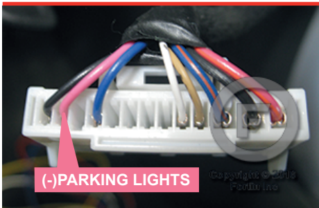
② At parking Lights switch Au commutateur des lumières de stationnement
