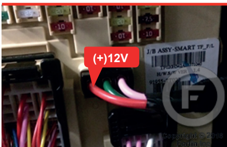
① In the front of the fuse box Boîte à fusible
