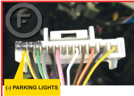
③ At Parking Lights switch connector Au connecteur du commutateur des lumières de stationnement
