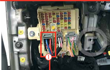
1 Fuse box. Boîte à fusibles.
