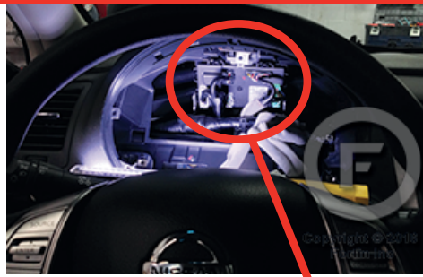
BCM located behind cluster BCM Situé derrière l'audomètre
