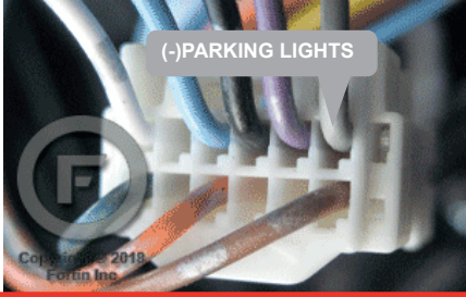
② at parking light harness. au harnais de feux de positionnement.
