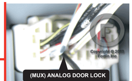
④ At driver's kick panel Au panneau latéral côté conducteur
