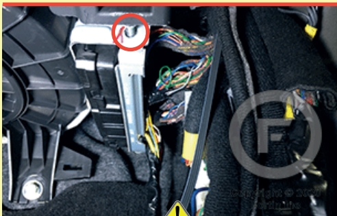
① Behind glove box Derrière le coffre à gants
