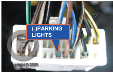
② At Parking light harness Au HArnais des feux de sttionnement
