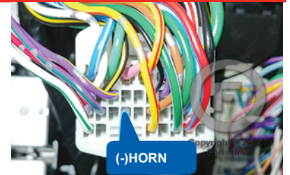
③C BCM Behind fuse box BCM À l'arrière de la boîte à fusibles
