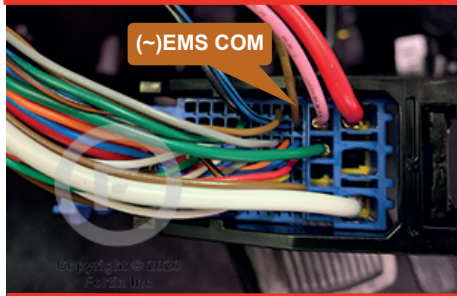
② Right of the fuse box À droite de la Boite à fusibles
